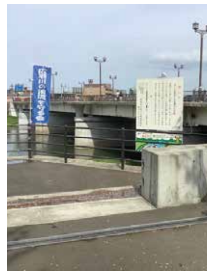
令和4年4月27日 委員会市内視察 広瀬橋
